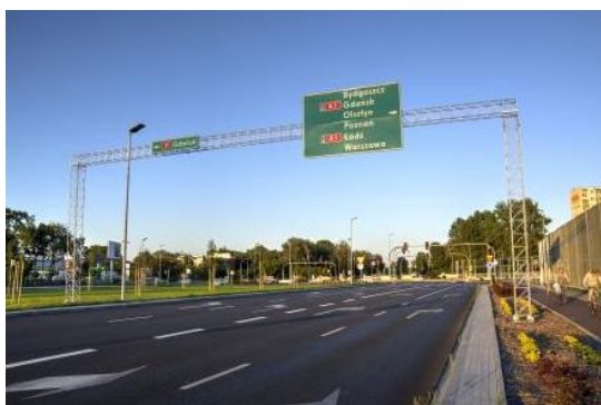
Rys. 17.10. Przykład konstrukcji bramownicy
