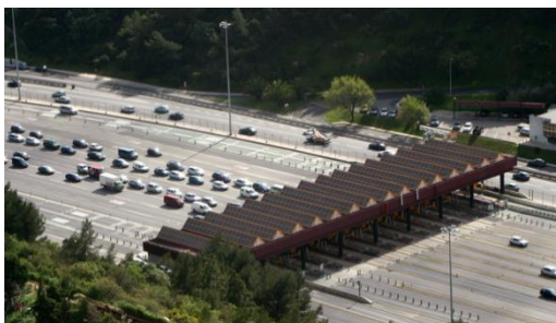
Rys. 17.12. Rozszerzone zadaszone miejsce na autostradzie do poboru opłat
