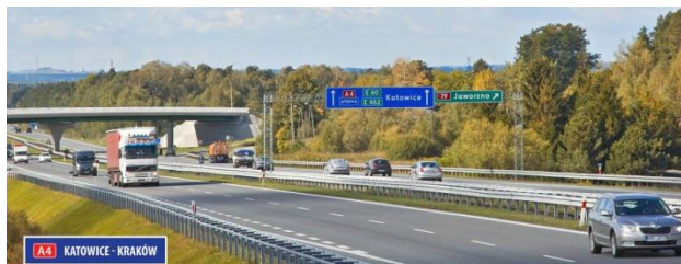
Rys. 17.4. Widok odcinka autostrady (Katowice – Kraków)
